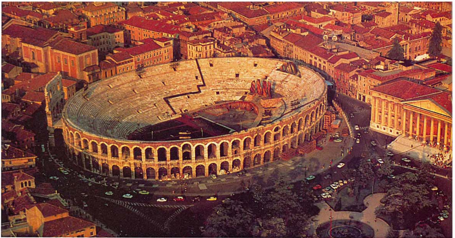
На этом аэрофотоснимке амфитеатра в Вероне видно, как возводились подобные сооружения: в центре — овальная площадка для боев (арена) с двумя противоположными входами, вокруг ярусами поднимаются ряды скамей. Амфитеатр в Вероне был сооружен в I в. после Р.Х. и вмещал 25 000 человек.
