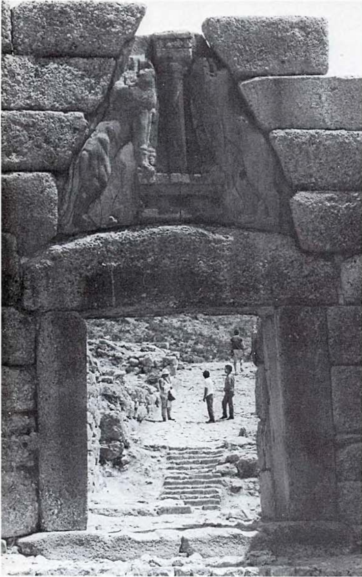
Львиные ворота в Микенах, одно из древнейших дошедших до нас архитектурных сооружений мира. Они были возведены в 1350 г. до Р. Хр. как вход в крепость Агамемнона.
