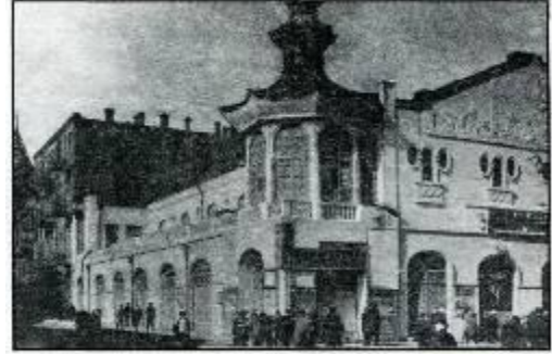
"Mikado" (indiki S.Vurğun adına Dövlət Rus Dram Teatrı) teatrının binası
