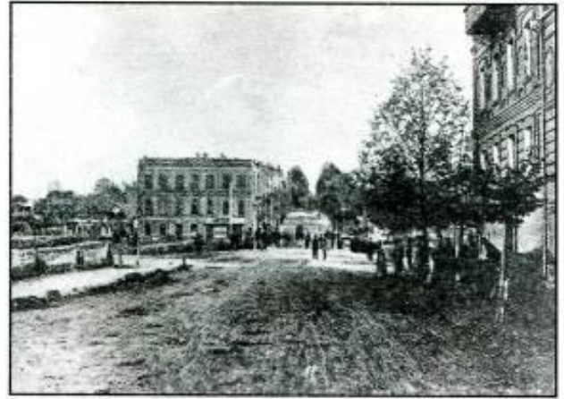
Gəncə quberniya idarəsinin binası. 19 əsrin sonları – 20 əsrin əvvəlləri
