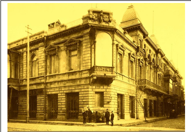
1920-ci ildə Azərbaycan Dövlət Muzeyinin H.Z.Tağıyevin evindəki binası
