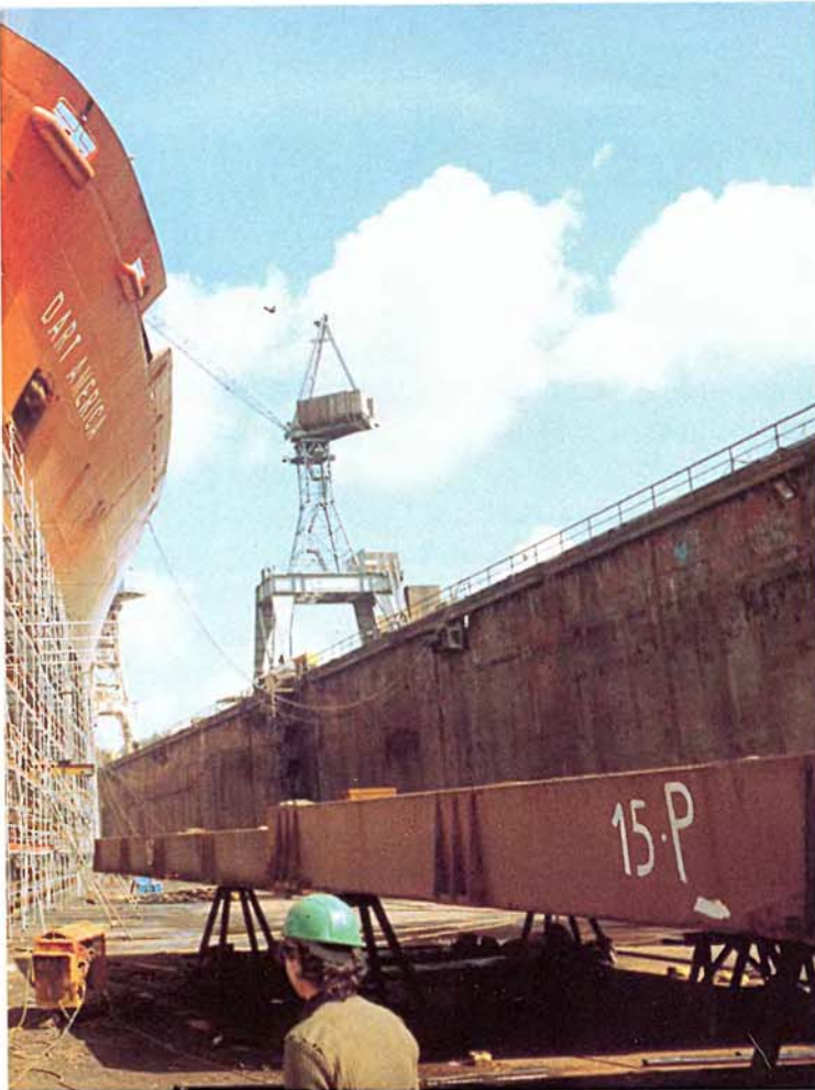
Контейнерное судно ремонтируют и красят в доке.
