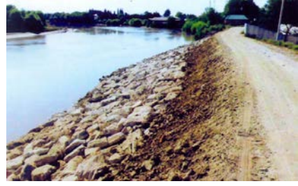
Zərdab rayonu, Kür çayında sahilbərkitmə işləri
