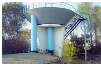
Ağdaş rayonu, Ağdaş-2 nasos stansiyası
