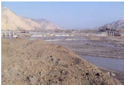
Göyçay çay hidroqovşağı
