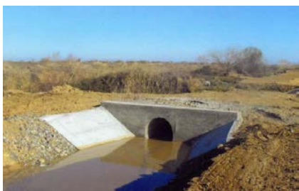
Beyləqan rayonu, Temirax kanalı
