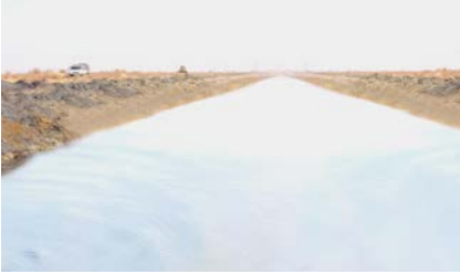
Baş Şirvan kollektoru (BŞK)
