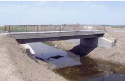
İmişli rayonu, Sol-sahil kollektoru üzərində körpü
