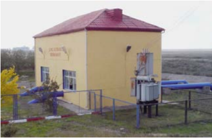
Füzuli rayonu, Qəsəbə 1 nasos stansiyası
