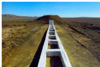
Ceyrançöl qış otlağı massivində suvat məntəqəsi
