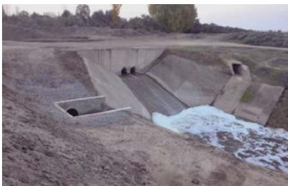
Saatlı rayonu, Sağ sahil kollektoru üzərində sudüşürən qurğu
