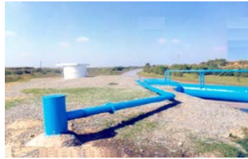
İmişli rayonu ərazisində artezian və siyirtməli quyu
