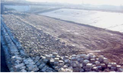
Vəlvələçay çayında sel və daşqın sularına qarşı mühafizə tədbirlərinin aparılması
