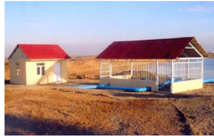
Şamaxı rayonu, Aşağıbəyli nasos stansiyası
