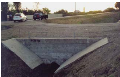
Yevlax rayonu, QD-3 kollektoru sistemində sukeçirənlər
