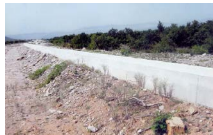
Şəki rayonu, Daşaqılçay çayında sel və daşqın sularına qarşı beton bənd
