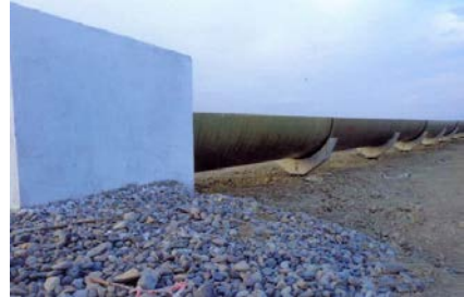
Kürdəmir rayonu, Söyüdlər nov kanalı
