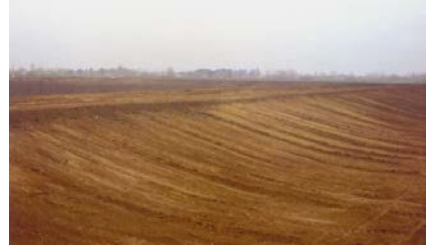
İmişli rayonu Qaradonlu kəndi ərazisində Araz çayının sağ sahilində möhkəmləndirmə və təmir-bərpa işləri
