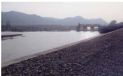
Göyçay çay hidroqovşağı
