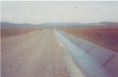
Şəki rayonu, Yeni Cəyirli kanalı
