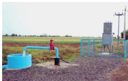
Ağdam rayonu, Camanı kəndində subartezion Quyusu
