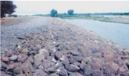
Ağstafaçay çayında sahilbərkitmə işləri
