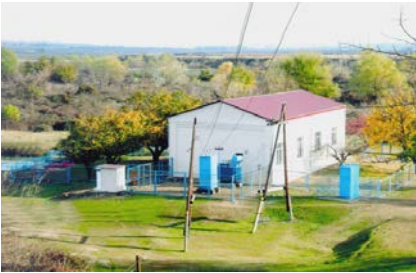
Qazax rayonu, Alpud nasos stansiyası
