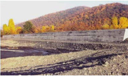
Zaqatala rayonu, Muxaxçay çayında sel və daşqın sularına qarşı beton bənd
