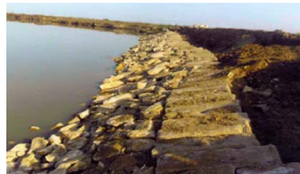
İmişli rayonu, Kür çayında sahilbərkitmə işləri
