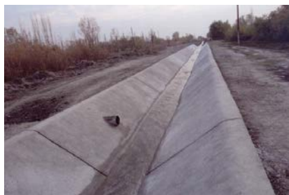
Göyçay rayonu, Yeni arx beton kanalı
