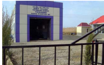
Şamaxı rayonu, Yənikənd nasos stansiyası
