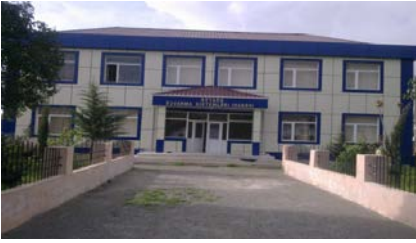
Astara Suvarma Sistemləri İdarəsinin inzibati binası
