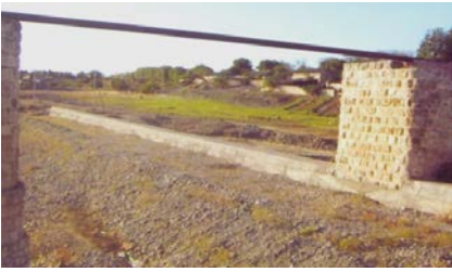
Tərtər rayonu, Tərtərçay çayında sel və daşqın sularına qarşı beton bənd
