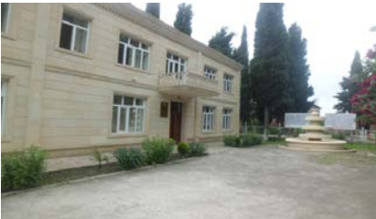
Tovuz Suvarma Sistemləri İdarəsinin inzibati binası
