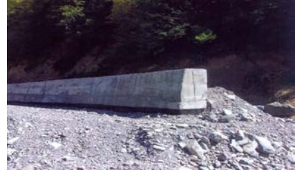
Qəbələ rayonu, Vəndamçay çayında sel və daşqın sularına qarşı beton bənd
