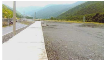
Qəbələ rayonu, Türyançay çayında sel və daşqın sularına qarşı beton bənd
