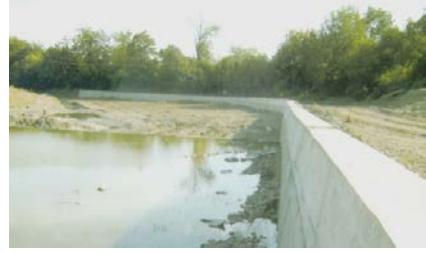
Astara rayonu, Pənsərçay çayında sel və daşqın sularına qarşı beton bənd
