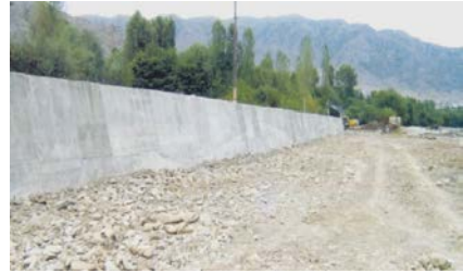
Tovuz rayonu, Zəyəmçay çayında sel və daşqın sularına qarşı beton bənd
