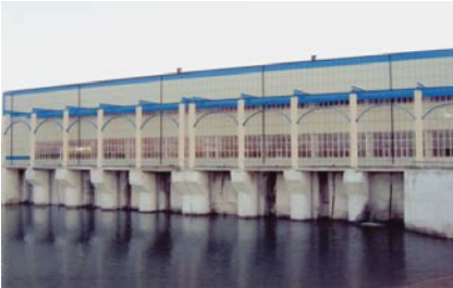
Şəmkir rayonu, II pilləli nasos stansiyası
