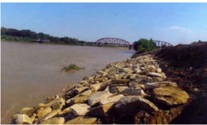
Şirvan şəhəri, Kür çayında sahilbərkitmə işləri
