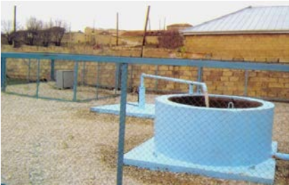
Qobustan rayonu, Dereshalbas kəndində artezian quyusu
