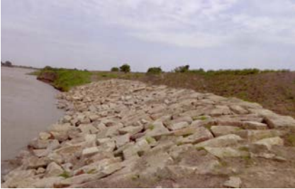
Sabirabad rayonu, Kür çayında sahilbərkitmə işləri
