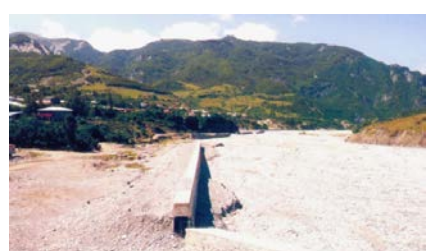
İsmayılı rayonu, Girdimaçay çayında sel və daşqın sularına qarşı beton bənd
