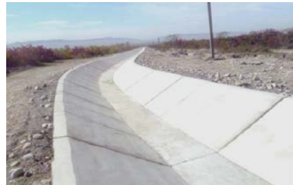
Şəki rayonu, Dəhnə kanalı
