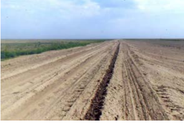
İmişli rayonu, Araz çayında sahilqoruyucu torpaq bənd
