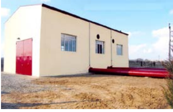
Goranboy rayonu ərazisində Qizilhacılı qış otlağı massivində nasos stansiyası
