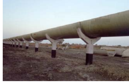
Kürdəmir rayonu, Sor-sor magistral nov kanalı
