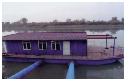
Ağcabədi rayonu, Kür çayında üzən nasos stansiyası
