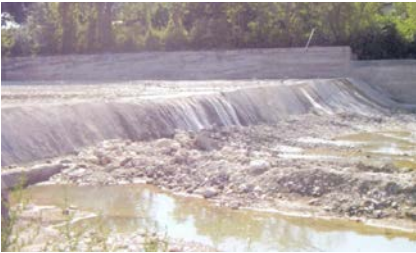
Ağsu rayonu, Ağsuçay çayında sel və daşqın sularına qarşı beton bənd
