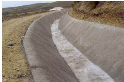
Göyçay rayonu, Qarayazı beton kanalı
