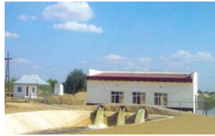
Kürdəmir rayonu, S kollektoru üzərində nasos stansiyası
