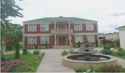
Tovuz Subartezian Quyularının İstismar İdarəsinin inzibati binası
