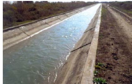
Kürdəmir R-5 kanalı
