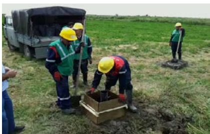
Rejim müşahidə quyusunun quraşdırılma prosesi
