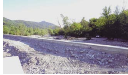
Oğuz rayonu, Xal-xalçay çayında sel və daşqın sularına qarşı beton bənd
